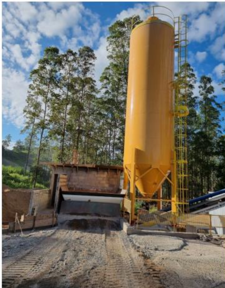
Imagem 1: depósito de brita, areia e pó de pedra para confecção do concreto, Relatório Fotográfico
