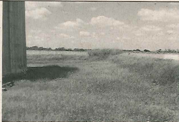
Foto 3: Bacia de contenção.
