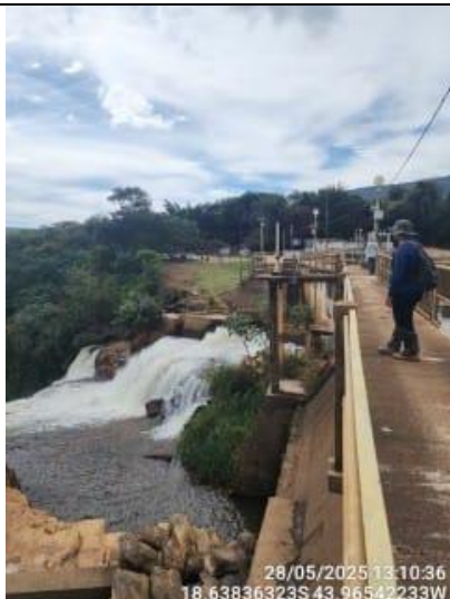
Foto 1. Vista da passarela e vertedor da CGH Paraúna.
