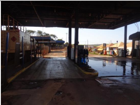
Figura 1- Pista de abastecimento
