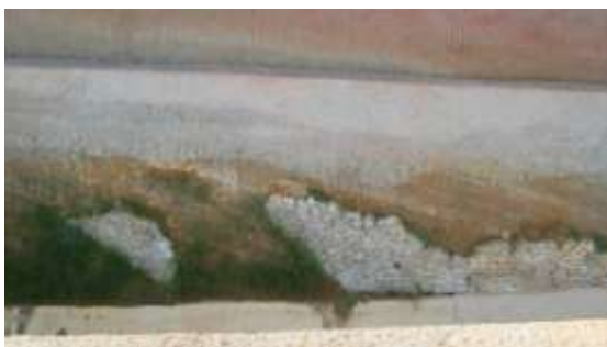
Foto 31: Talude em processo de revegetação na barragem nova na Fazenda Dourados
