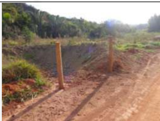
Foto 27: Uma das bacias de contenção existente ao longo das estradas.
