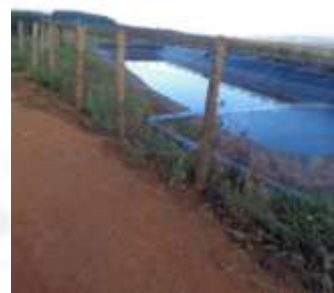
Foto 06: Bacia de contenção de água residual via úmida
