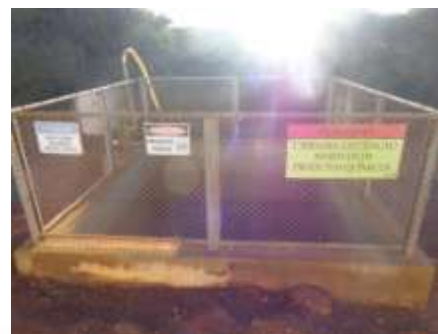
Foto 16: Caixa de contenção de resíduos da lavagem de equipamentos contaminados por produtos químicos
