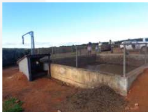
Foto 05: Caixa contenção água residual via úmida
