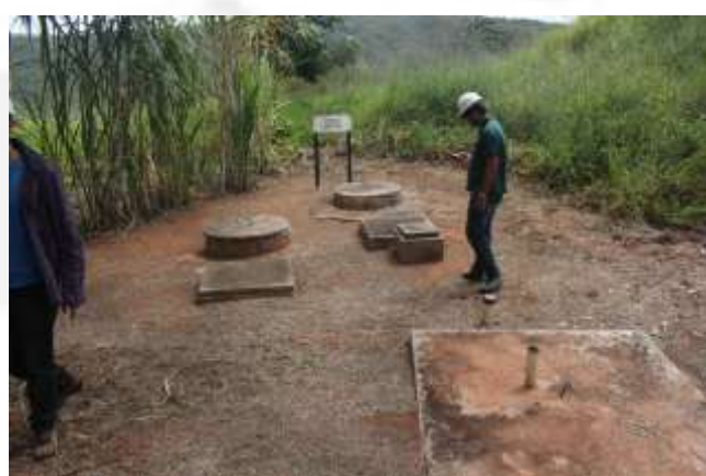
Foto 16. Fossa séptica na subestação Irapé.
