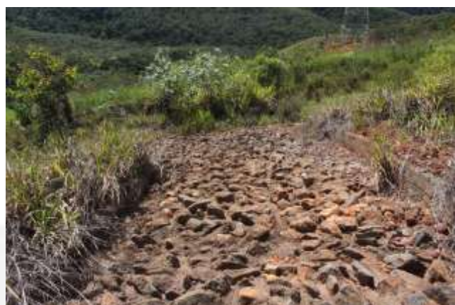
Foto 12. Sistema de redução de velocidade na saída do sistema de drenagem da subestação Irapé
