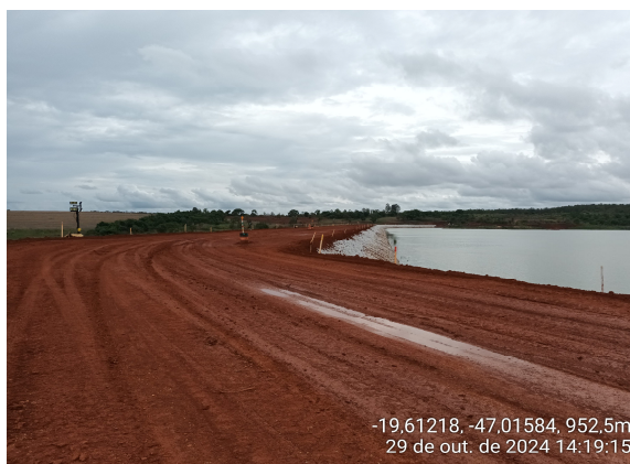
Foto 04. Barragem B6 - Alçamento cota 965 m.
