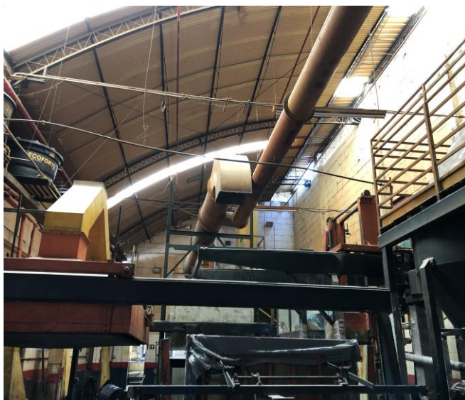
Foto 05. Sistema de exaustão que conecta os reatores de espuma e a chaminé de exaustão.
