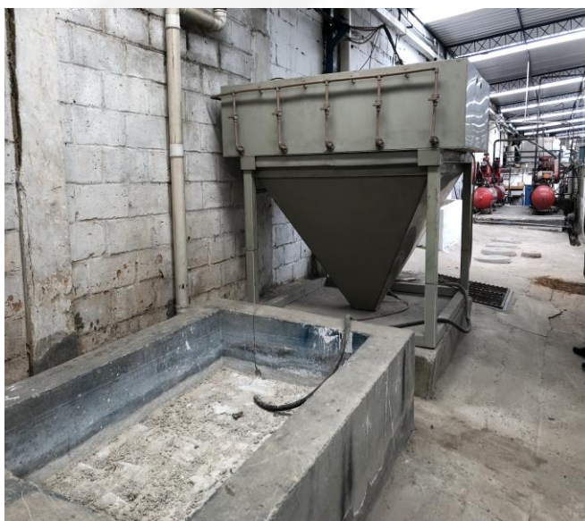
Foto 07. Sistema de Mini ETE e caixas separadoras de água e óleo (CSAO) aos fundos.
