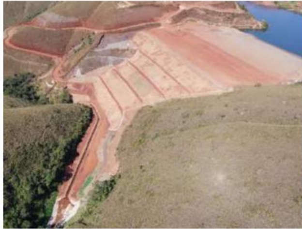
Figura 2-2 - Vista aérea da Barragem de Rejeitos dos Alemães após a conclusão das obras do aterro do maciço de adequação de jusante.
