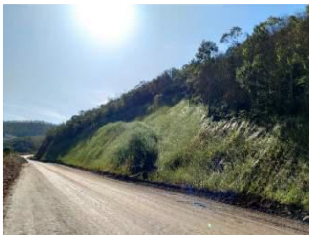
Figura 2-6 – Local após a obra de recuperação (junho de 2022)
