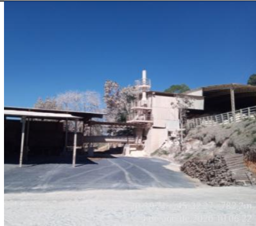
Foto 01. Forno rotativo e chaminé.
