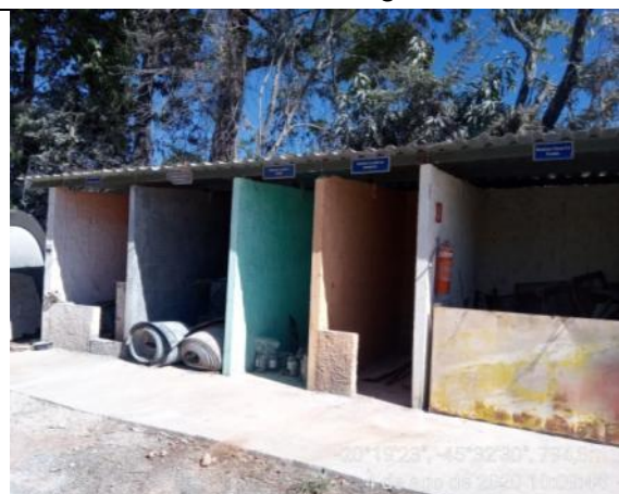
Foto 06. Local separação e armazenamento resíduos
