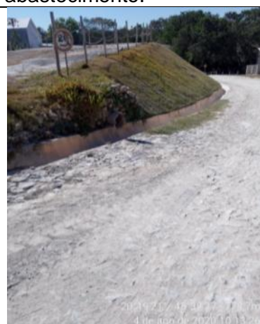
Foto 12. Vias calçadas e sistema de drenagem pluvial.
