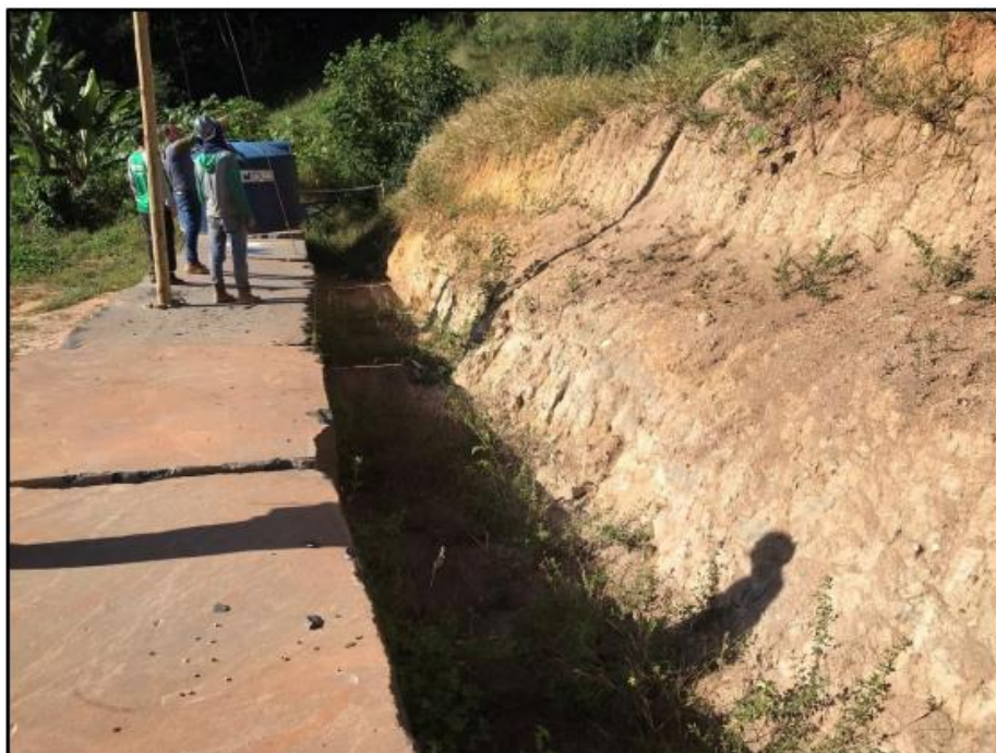
Canaleta de drenagem pluvial e contenção por blocos na pilha de estéril/rejeito (Fonte: RCA)
