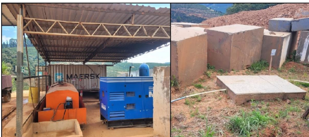
Área do ponto de abastecimento e a respectiva caixa SAO
