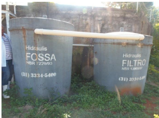
Foto 4: Fossas Sépticas Fonte: RCA
