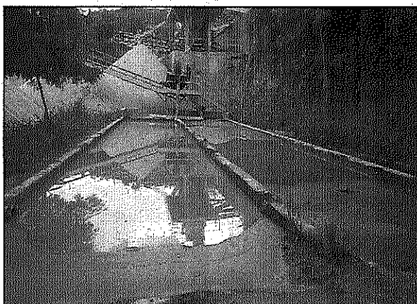
Foto 05. Bacia de decantação de finos do processo de produção da areia lavada.
