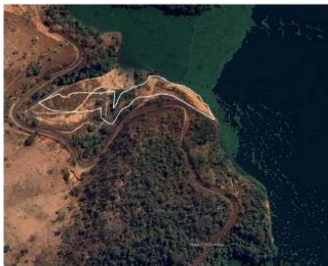
Imagem 4: Área após intervenção realizada pela RENOVA para disposição de sedimentos dragados.
