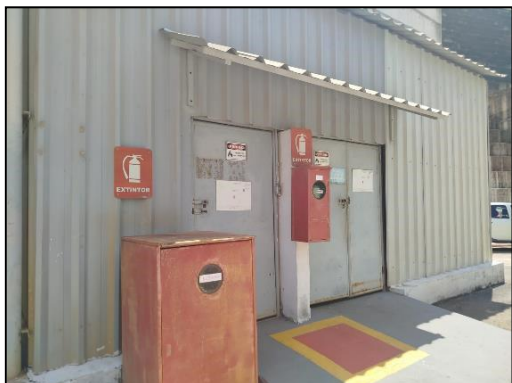
Foto 5: Depósito Temporário de Produtos Perigosos - área externa
