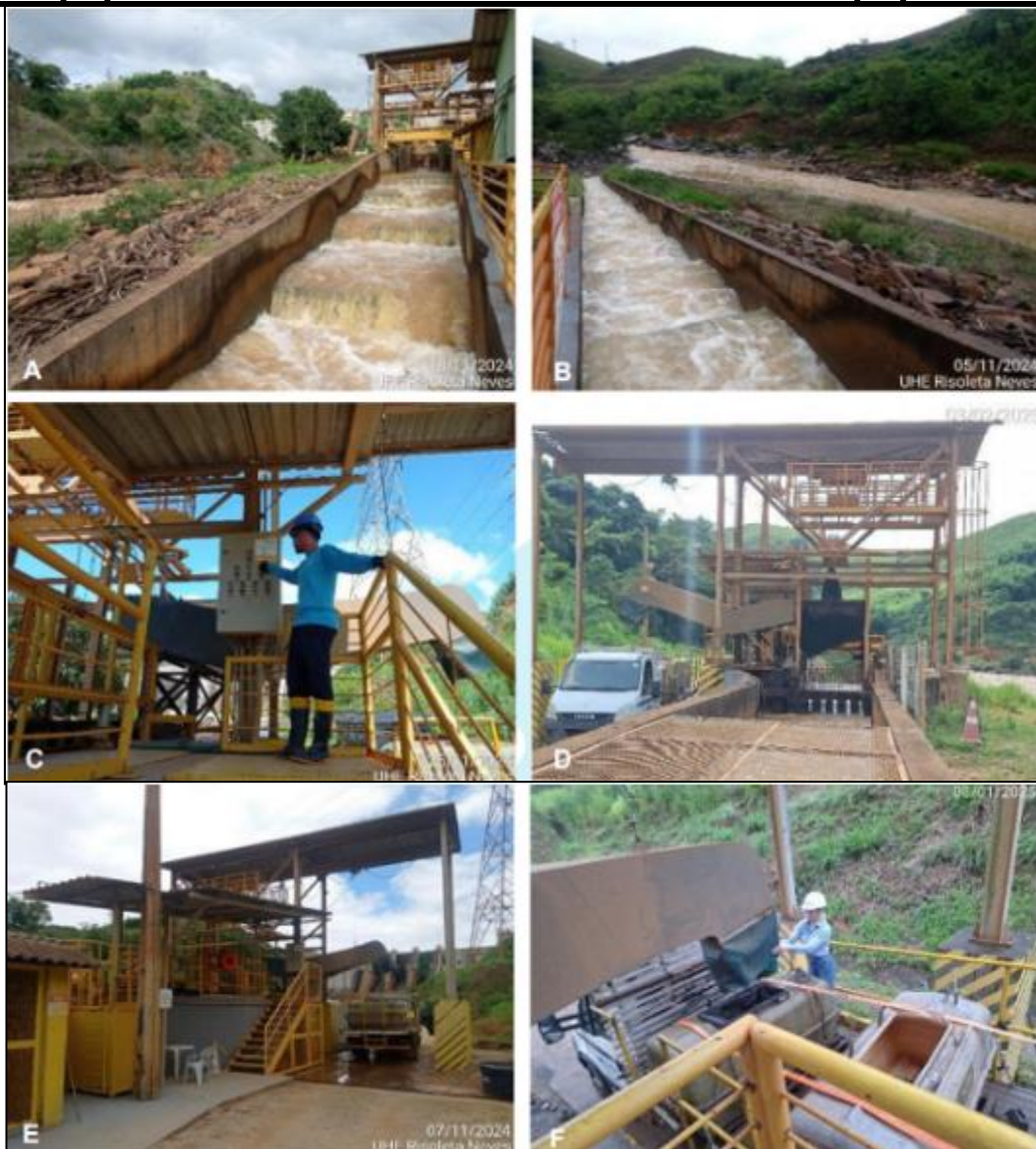
Imagem 11: Sistema de Transposição de Peixes (STP) da UHE Risoleta Neves. Imagem A/B: Escada do STP; C: Operação da Caçamba; D: Caçamba içada e acoplada a uma estrutura tipo calha (elevador); E/F: Calha direcionada para as caixas de transporte de peixes ( transfish ), posicionadas no caminhão (Fonte: Relatório Anual Piracema 2024/2025).
