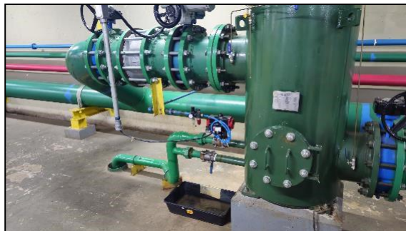
Foto 10: Sistema de drenagem de percolados (canaleta ao pé da parede)
