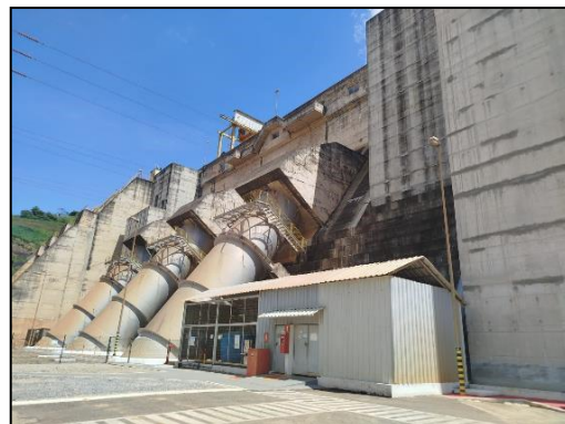
Foto 2: Condutos forçados
