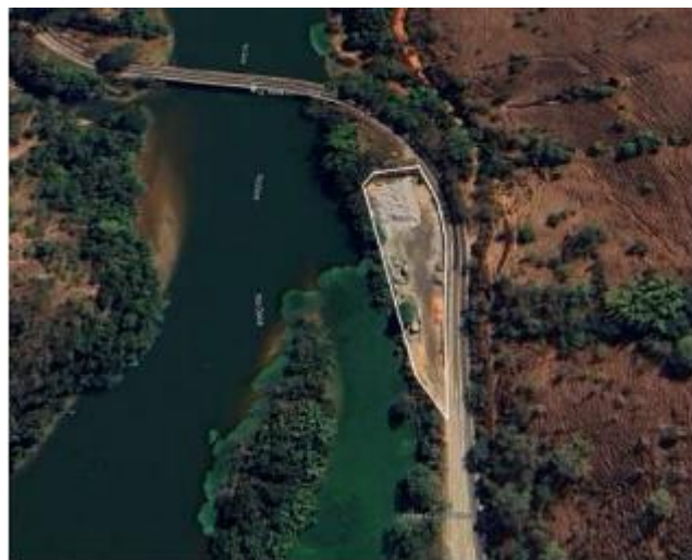
Imagem 6: Intervenção próxima a ponte do rio Doce realizada pela Fundação RENOVA.
