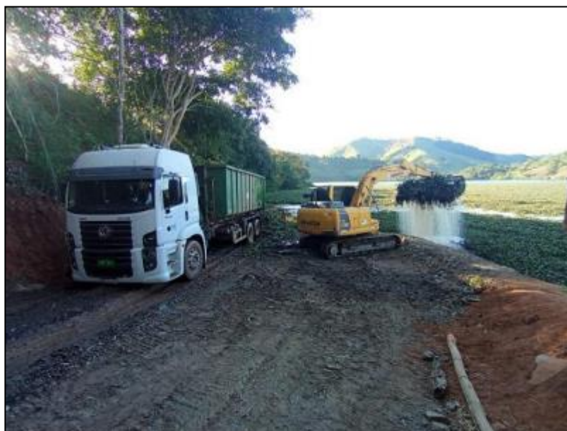
Imagem 15: Processo de remoção das macrófitas aquáticas e carregamento do material no caminhão para transporte até a área de manejo. (Fonte: Programa de Monitoramento de Macrófitas – Id SLA 354818).
