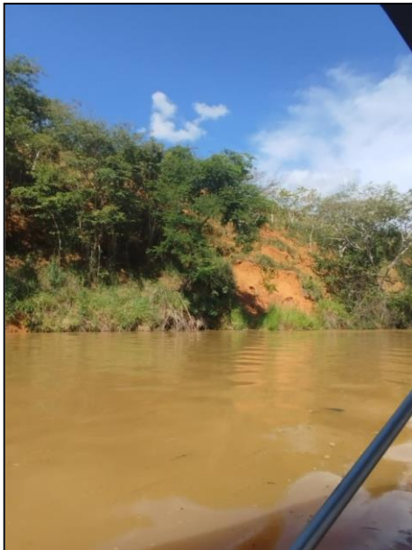
Foto 17: Processo erosivo nas margens do reservatório
