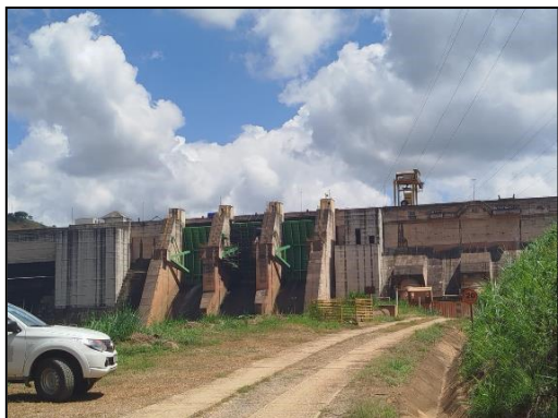
Foto 1: Vista geral do barramento principal
