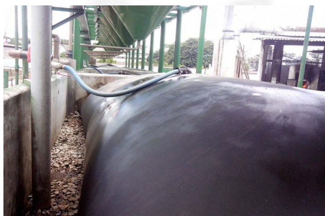
Detalhe abaixo decantadores com bag filtrante em leito de brita Foto 08.
