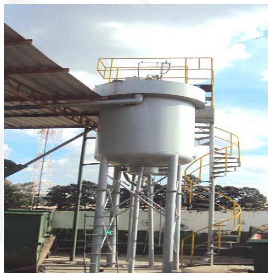
Flotador de gordura linha vermelha Foto 04.
