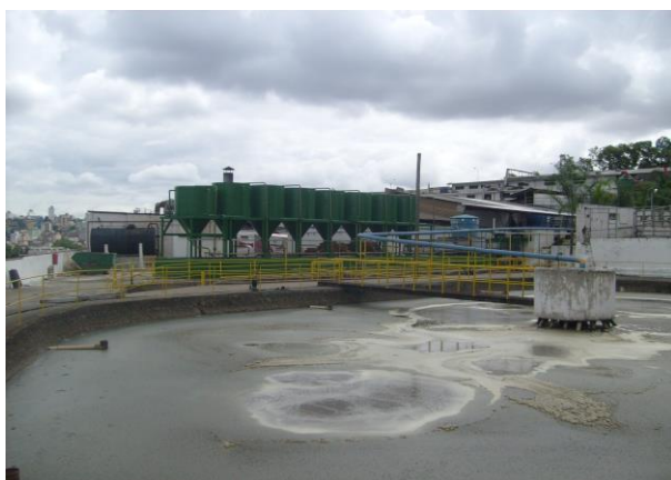
Visão lagoa anaeróbica e decantadores secundários Foto 05.
