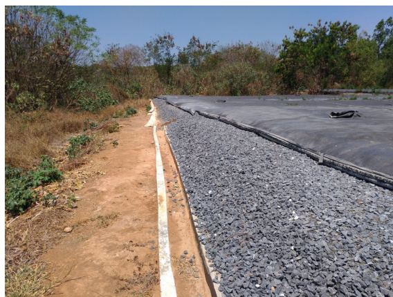
Foto 04. Armazenamento de lodo removido da lagoa anaeróbica
