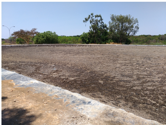
Foto 13. Lagoa anaeróbica com material flotante.
