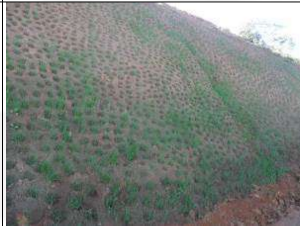
Foto 4 – PRAD: Estabilização de taludes.
