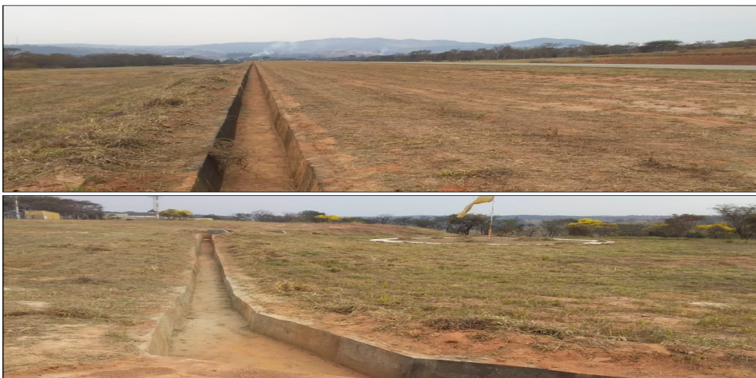
Figura 07: Parte do sistema de drenagem pluvial. Fonte: Estudos Ambientais
