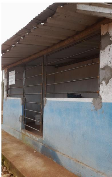
Figura 07: Baia de segregação resíduos oleosos com adequação solicitada. Fonte: Informação complementar.
