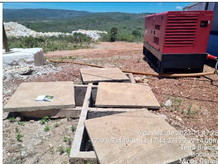
Figura 06: Sistema de tratamento efluente oleoso - CSAO Fonte: URANM, 2023.
