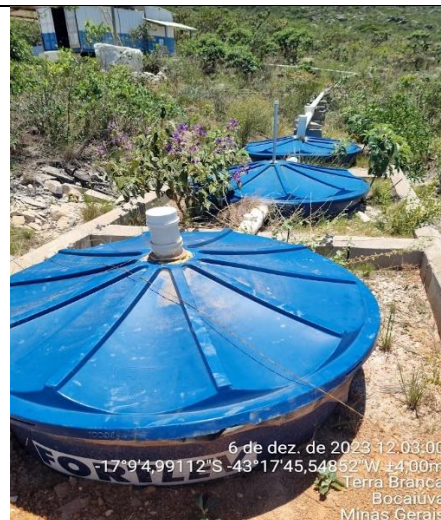
Figura 02: Sistema de tratamento de efluente sanitário do Modelo Embrapa. Fonte: URA NM, 2023.
