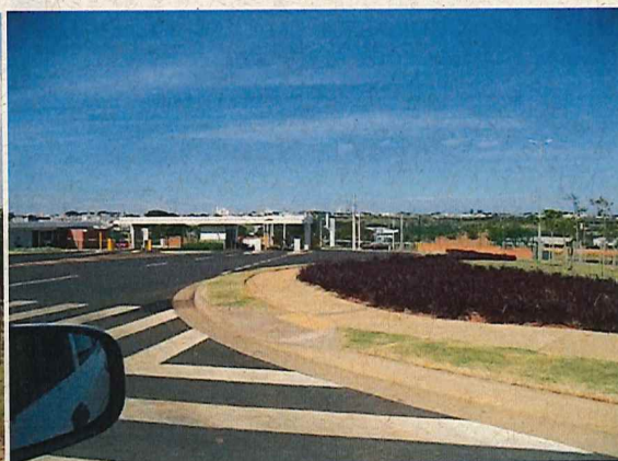
Foto 04- Vista da portaria
