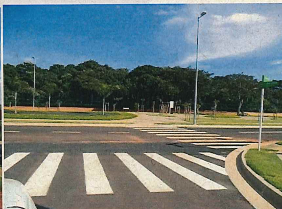
Foto 02- Área externa de circulação
