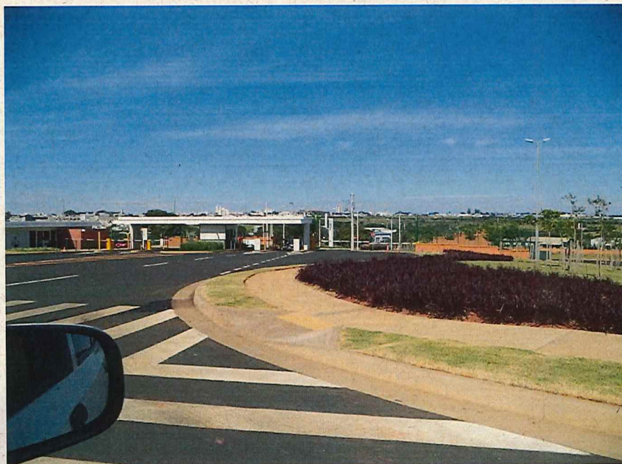
Vista da portaria
