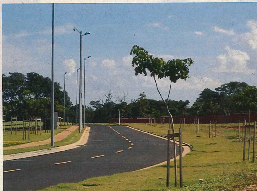
Área Interna, pavimentação
