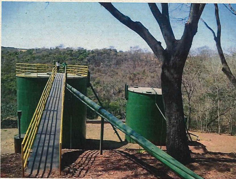
Foto de vistoria à ETE- Granja Marileusa
