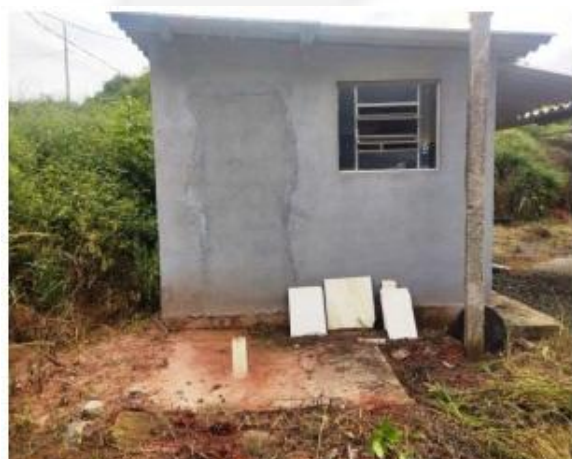
Foto 08: fossa séptica e biodigestor.
