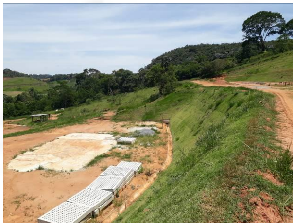
Foto 08. Revegetação de talude
