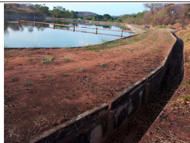
FIGURA 11 e FIGURA 12. Sistema de drenagem pluvial implantado no empreendimento. Fonte: Informações Complementares.
