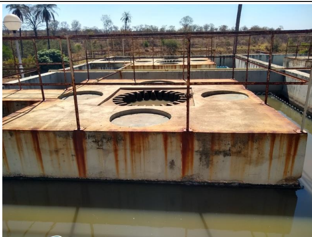
FIGURA 07. Reator Anaeróbico. FONTE: RAS ETE Coração de Jesus, 2019.
