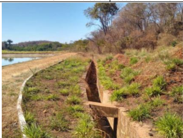
FIGURA 11 e FIGURA 12. Sistema de drenagem pluvial implantado no empreendimento. Fonte: Informações Complementares.
