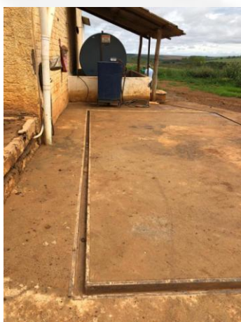
Ponto de abastecimento. Bacia de contenção e canaletas.
