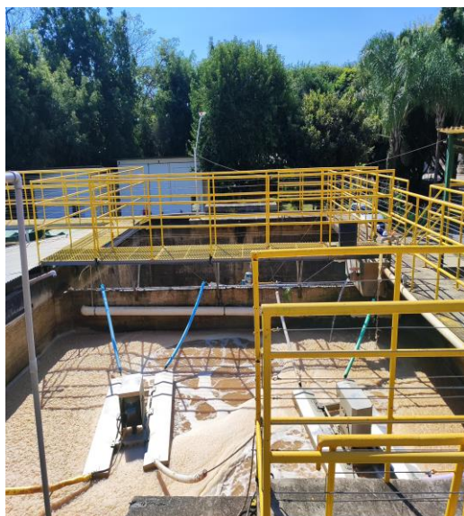
Foto 5: Tanque de aeração
