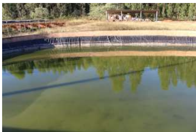
Foto 03: Tanque impermeabilizado.
