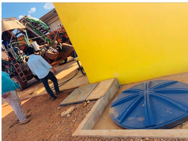
Caixa retentora de efluente da pista de abastecimento de defensivo agrícola
