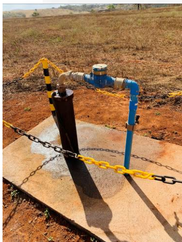
Ponto de captação – Poço Tubular
