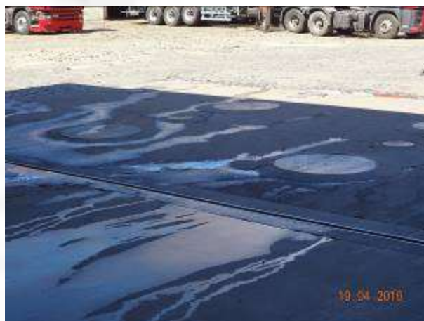
Foto 2 – Pista de abastecimento com caída em direção as caneletas.
