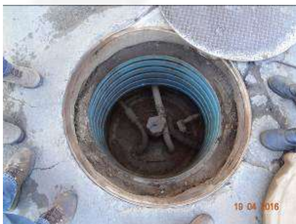
Foto 7 – Sistema de controle intersticial instalado na boca de visita.
