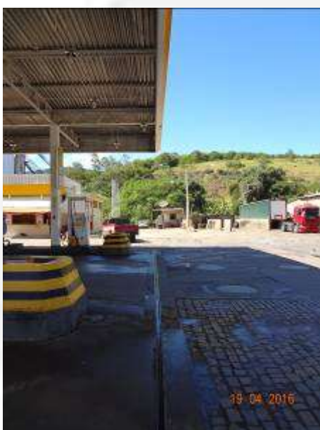
Foto 1 – Caneletas seguem a projeção da cobertura da pista de abastecimento.
