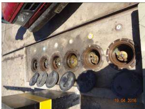
Foto 11 – Descarga a distância, todas com SUMP.
