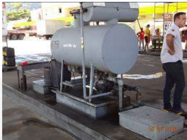
Foto 10 – Filtro de diesel com SUMP.
