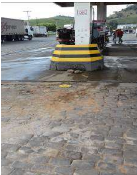
Foto 9 – poços de monitoramento de águas subterrâneas.
