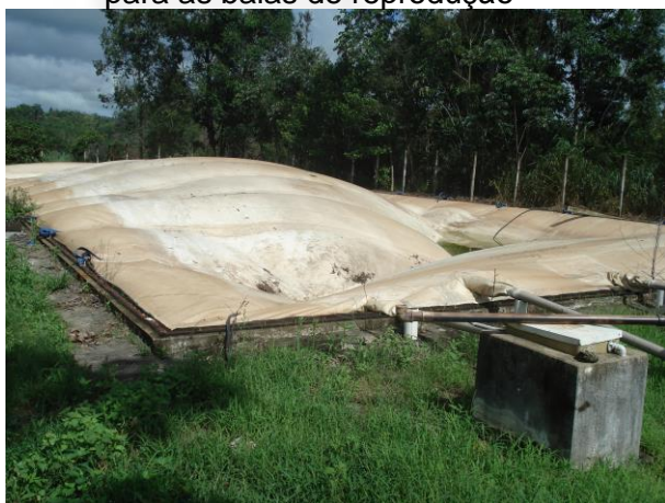
Foto 03. Biodigestor antes da desativação.
