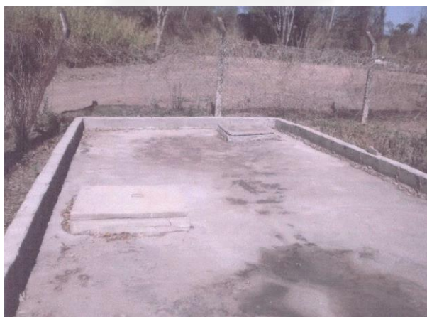
Foto 07. Tanques de acumulação de resíduos das baias de suínos.
