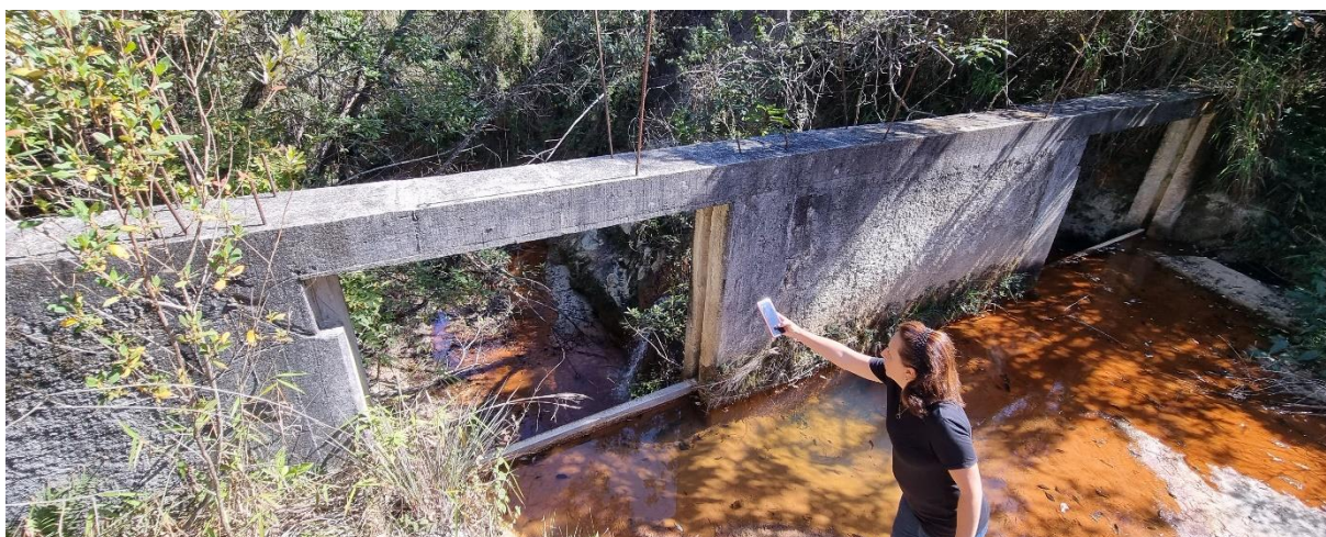
Figura 3 – Barramento para contenção do sedimento arenoso
