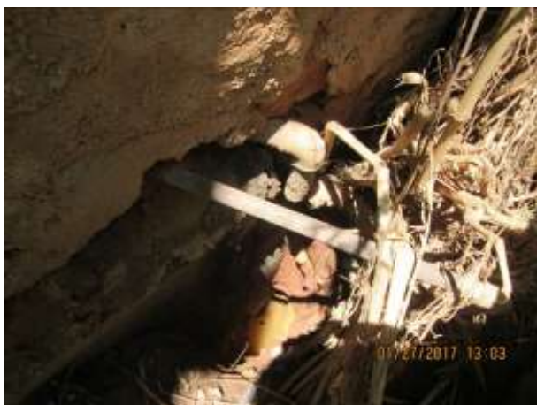
Fig. 17 - Purga da caldeira sendo direcionada diretamente para o curso d'água e causando princípio de erosão.
