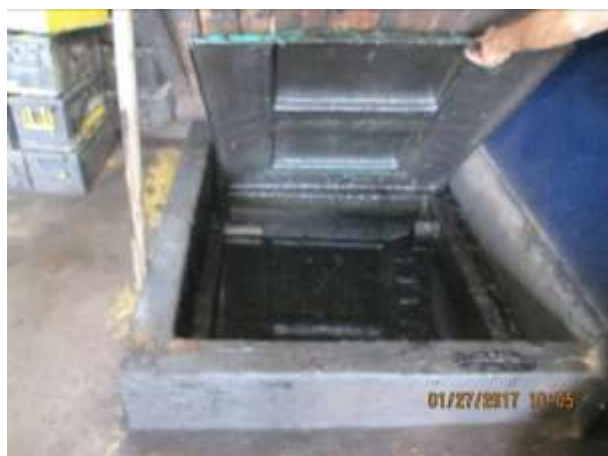
Foto 5 – caixa que deveria servir como separadora de água e óleo totalmente assoreada e cheia de óleo.
