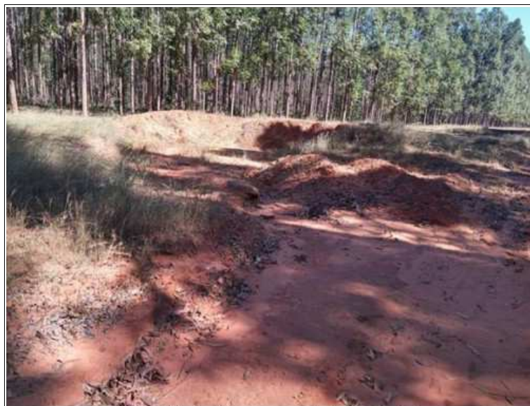
Imagem 2: Bacia de contenção das águas pluviais
