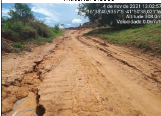
9. Estradas com sulcos erosivos
