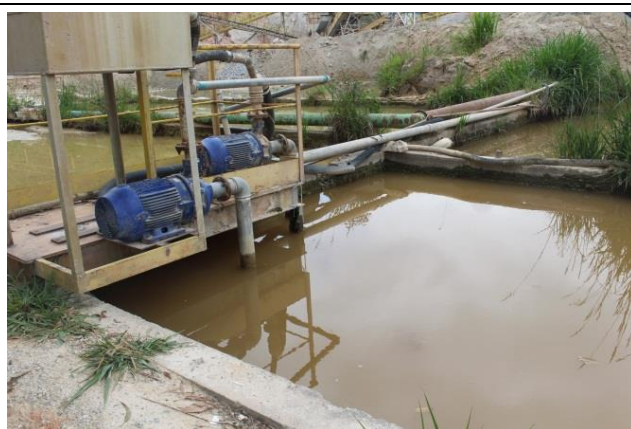
Foto 10: Sistema de recirculação/reuso de água.
