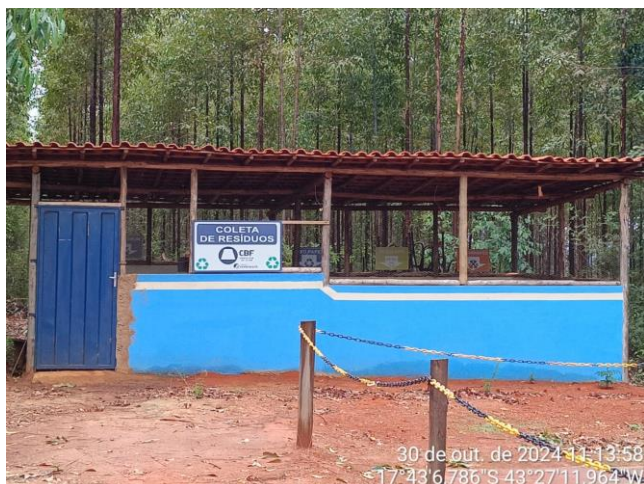
Foto 3 – Depósito de resíduos sólidos Tamboril.
