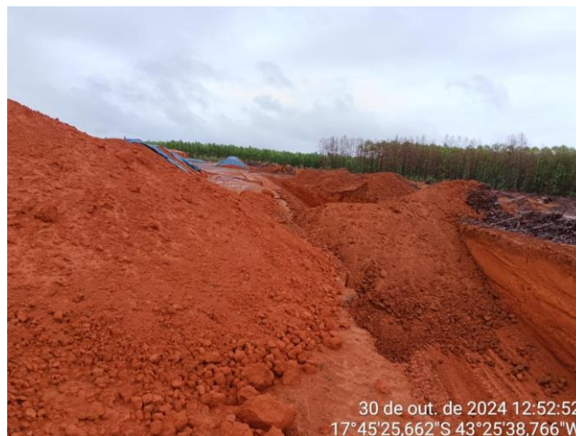
Foto 8 – Escavação (bacia de decantação) e argila utilizada para barrela (UB Lavrinha).
