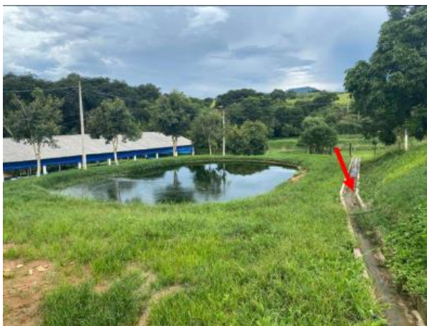
Foto 09. Canaletas de drenagem pluvial.
