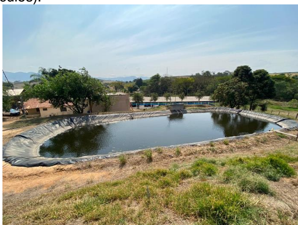
Foto 03. Lagoa de decantação e sistema de bombas para recirculação de água (lavagem de pocilgas)
