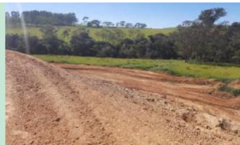
Foto 4.1-46: Evidência fotográfica da construção de contenções, dissipadores de energia em locais estratégicos, diques de contenção/curvas de níveis na área de menor declive afim de diminuir a força da água.
