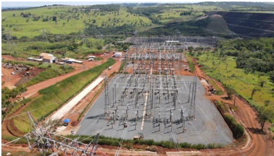
FIGURA 2.5: 500 kV NOVA PONTE – NOVO PÁTIO 345 kV E TRANSFORMAÇÃO 500/345 kV. FONTE: RT DE SITUAÇÃO, 2023
