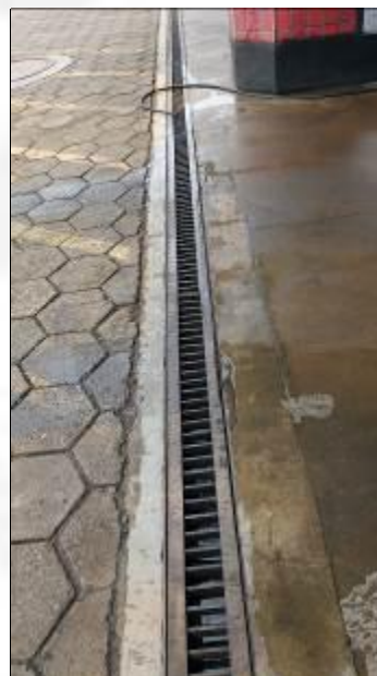
Foto 02. Canaletas ao redor da pista de abastecimento.
