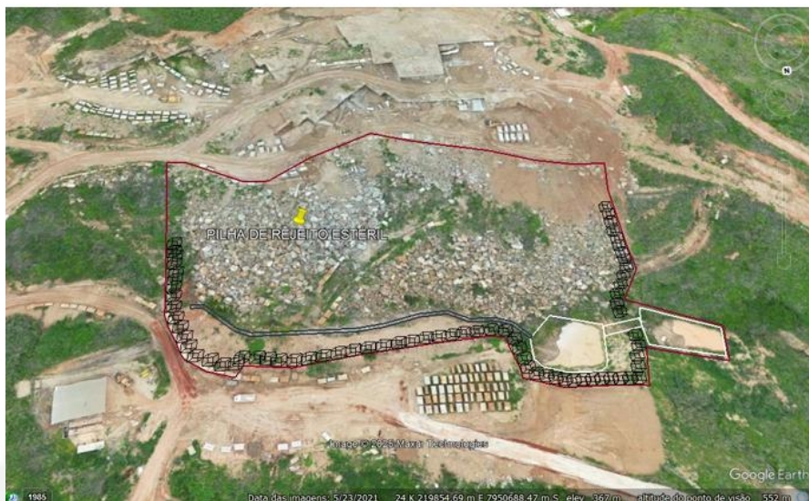
Figura 4. Pilha de rejeito/estéril do empreendimento (polígono vermelho). Fonte: Autos PA 29667/2025.
