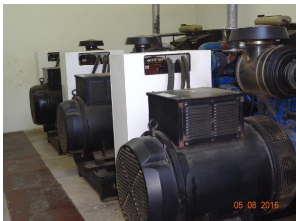
Fig. 9 – geradores movidos a Diesel
