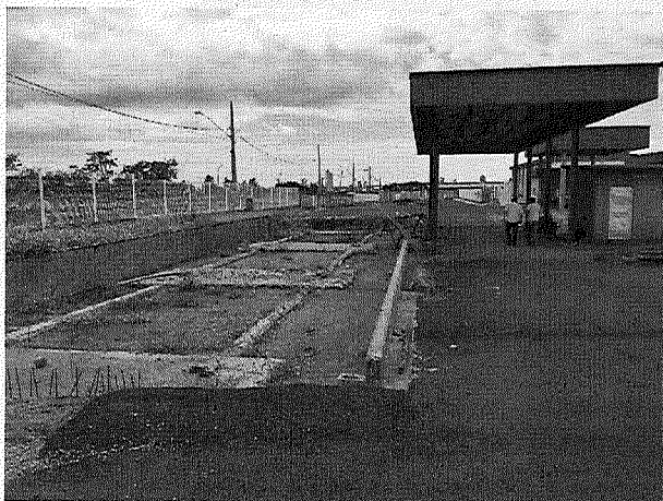
Foto 01: Área auxiliar - balança e lavagem de caminhões (18°50'44.68"S/48°17'42.95"O); 30/11/2018.
