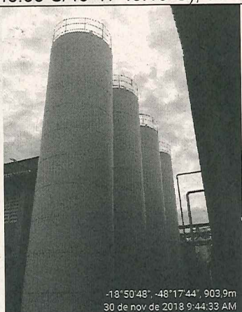
Foto 09: Área auxiliar - reservatórios de água (18°50'48.29"S/48°17'44"O); 30/11/2018.
