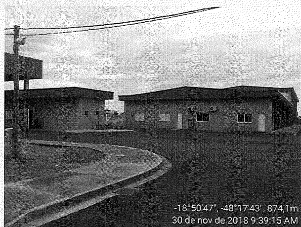
Foto 02: Vista geral da guarita e área administrativa (18°50'47"S/48°17'43"O); 30/11/2018.
