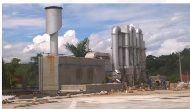
Sistema de tratamento de emissões atmosféricas
