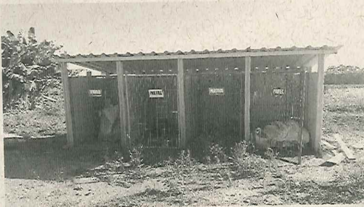
Centro de triagem de resíduos sólidos
