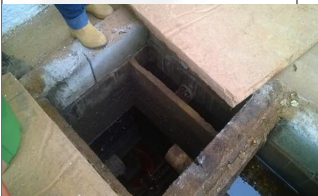
Figura 07: Caixa separadora de água e óleo.
