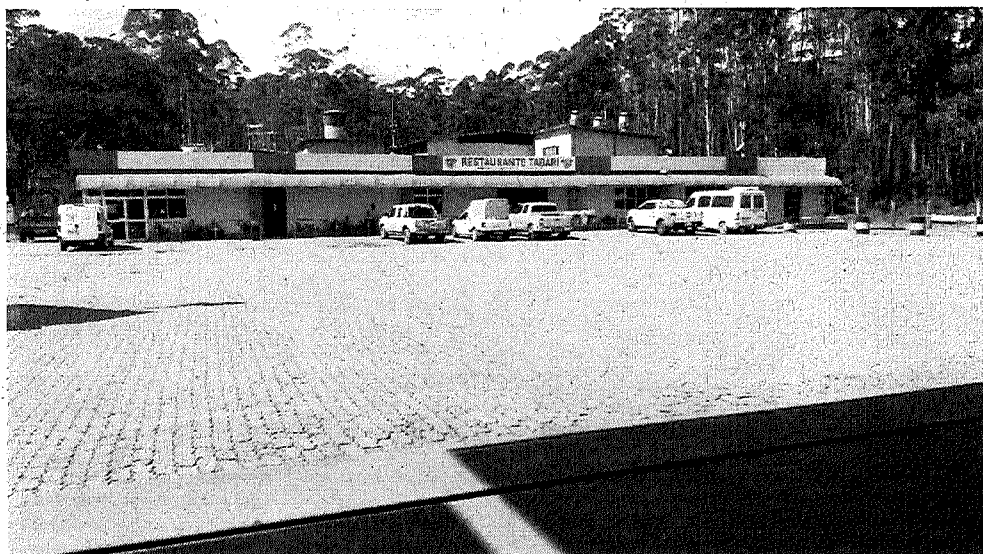
Foto 9 – Instalações do escritório, banheiros e restaurante.
