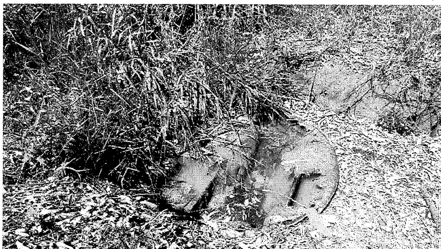
Foto 15 – Tampa da fossa, consumida por incêndio.
