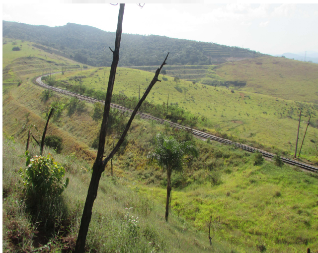
Foto 07: Ferrovia existente limítrofe a ADA do empreendimento.
