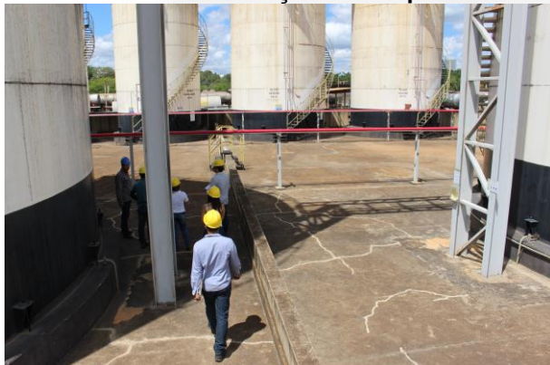
Foto 01: Local de instalação do tanque TQ – 2407
