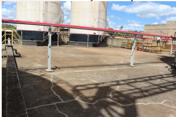
Foto 02: Local de instalação do tanque TQ – 2407
