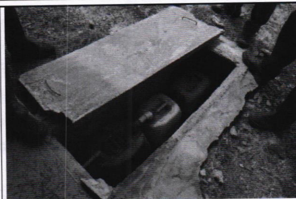
Foto 06: Caixas separadoras de água e óleo sem uso
