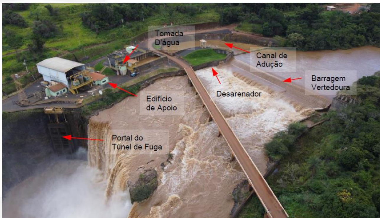
Figura 03: Vista aérea das principais estruturas da PCH Pai Joaquim. Fonte: SEI - Relatório de Informações Complementares (59221337).
