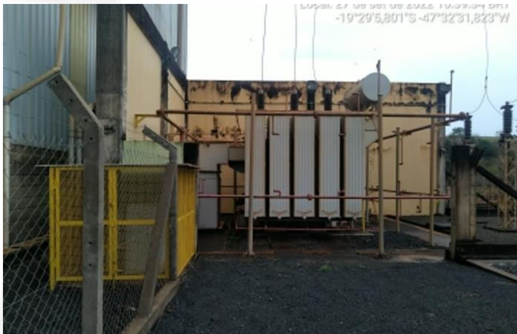
Figura 10: Transformador Elevador.
