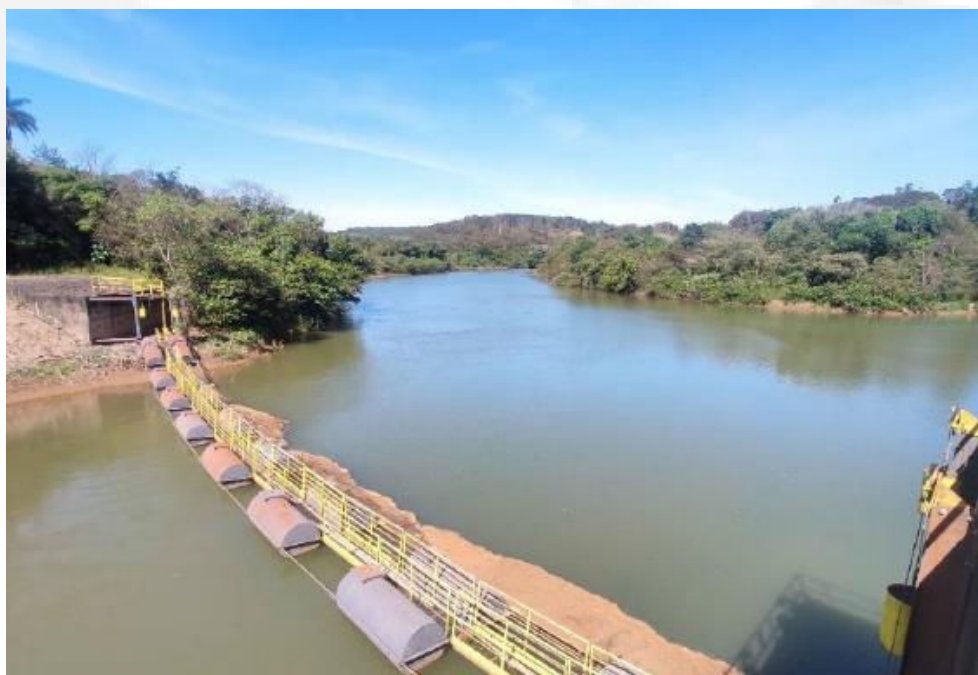
Figura 06: Log-boom instalado no início do canal de adução.
