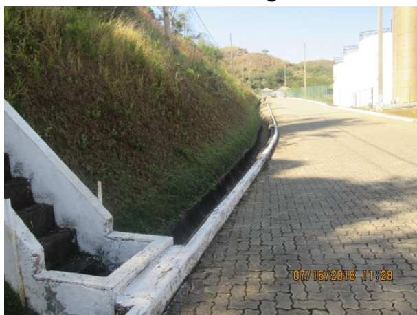
Foto 01. Escada hidráulica de drenagem pluvial
